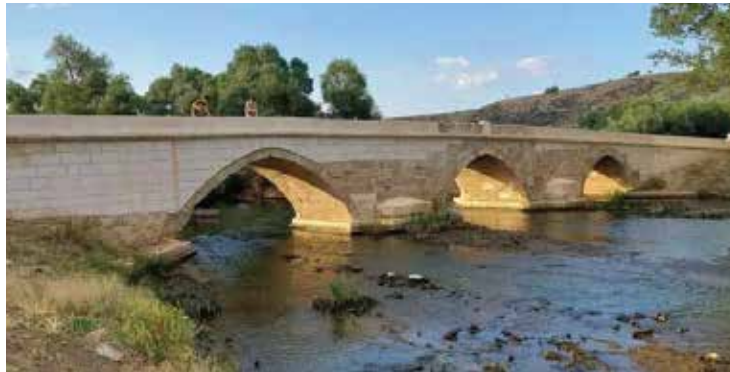
ÇOLAKLI KÖPRÜSÜ YOZGAT
