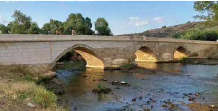
ÇOLAKLI KÖPRÜSÜ YOZGAT
